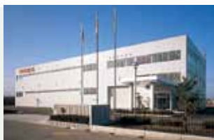
▲第二工場 Second Plant
